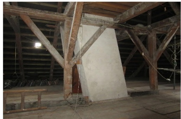
Abb. 147 Kehlbalken mit Holzbalken und Stützen
