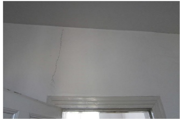
Abb. 106 Riss in innere Längswand
