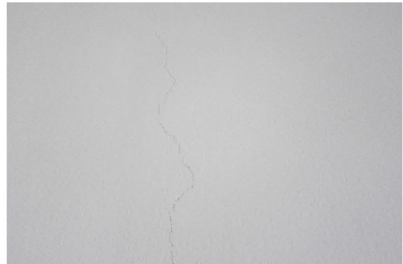
Abb. 135 Riss in der Giebelwand
