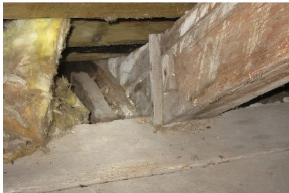
Abb. 150 geschädigter Sparrenfußpunkt
