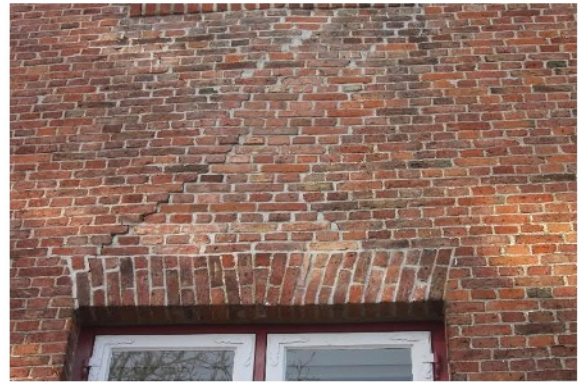
Abb. 184 verschobener Riss an der Haupttreppe
