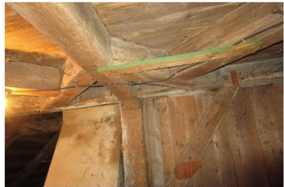
Abb. 154 Kehlbalcken von Mittelschiffe und Gratsparren
