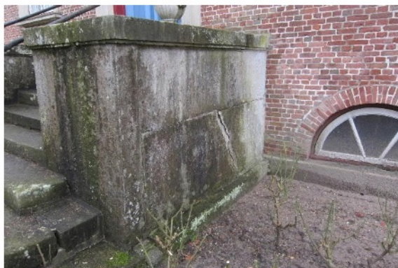
Abb. 17 Riss in Betonquader rechts
