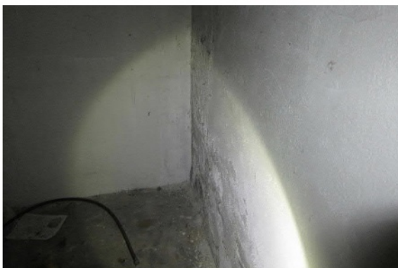
Abb. 54 Feuchtigkeit an Wandfuß
