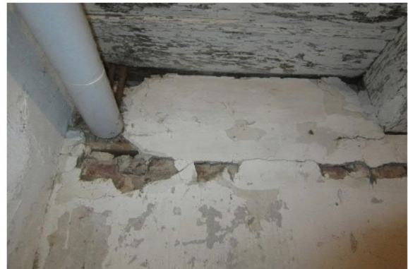
Abb. 35 Außenwand mit Holzschwelle für die Decke
