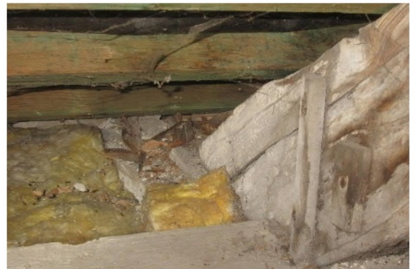
Abb. 151 geschädigter Sparrenfußpunkt
