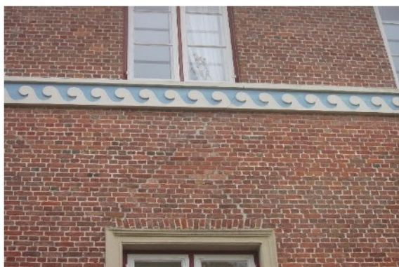
Abb. 175 Geschlossene Fuge leicht erneut gerissen
