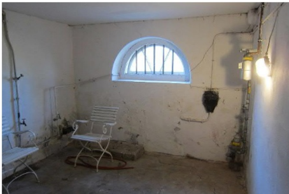
Abb. 74 Außenwände mit Feuchtestellen
