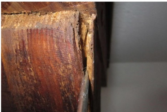
Abb. 159 Insektenbohrlöcher im Holz
