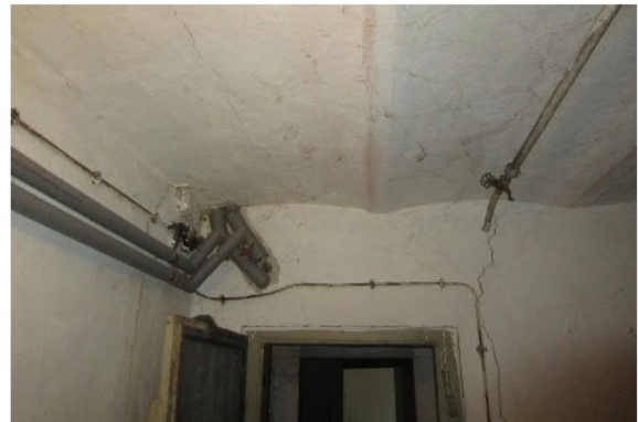
Abb. 65 Längsriss in Randkappe
