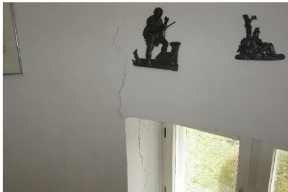
Abb. 7 Riss in der ausgerundeten Außenwand
