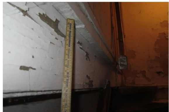
Abb. 90 Deckenaufbau über der Balkenlage
