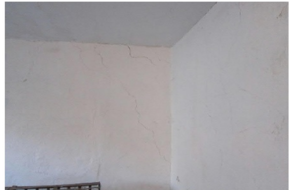
Abb. 73 Risse in Querwand und innen Längswand
