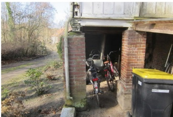
Abb. 27 Stützenschiefstellung
