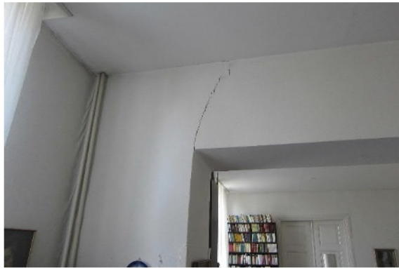
Abb. 105 Riss in Leichtwandsturz
