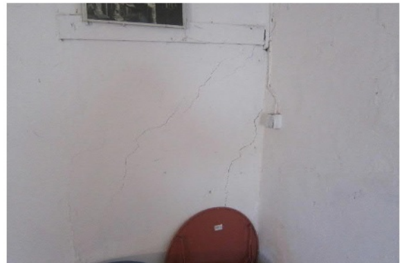
Abb. 75 Riss in Längsquerwand
