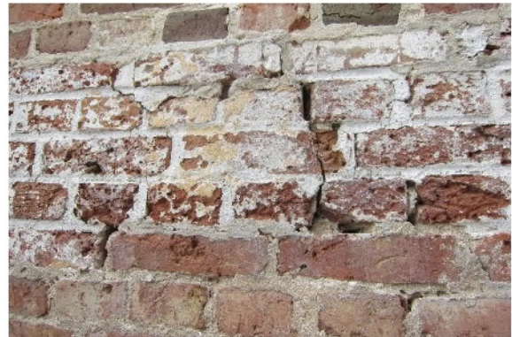
Abb. 168 weiße Beschichtung und Strukturschäden
