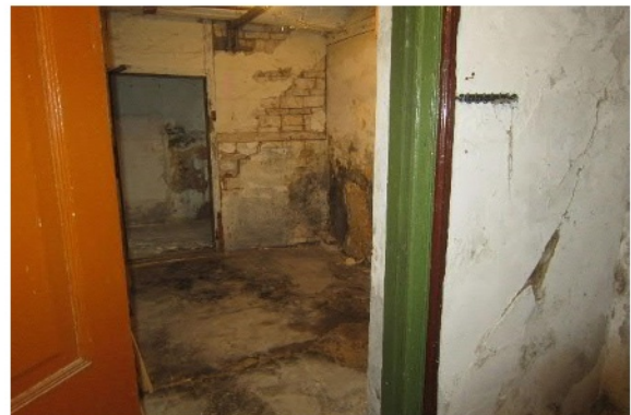
Abb. 37 Innere Querwand mit Riss
