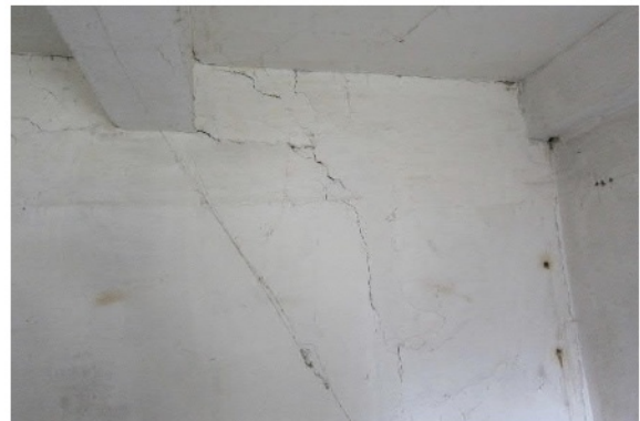
Abb. 85 Risse am Auflager
