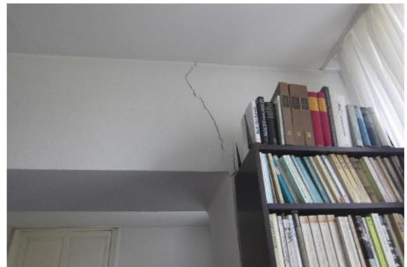
Abb. 104 Riss in Leichtwandsturz
