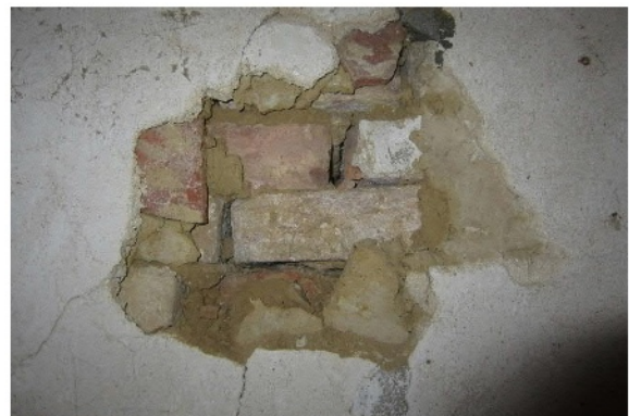
Abb. 47 Mauerwerksschäden Wohnungstrennwand
