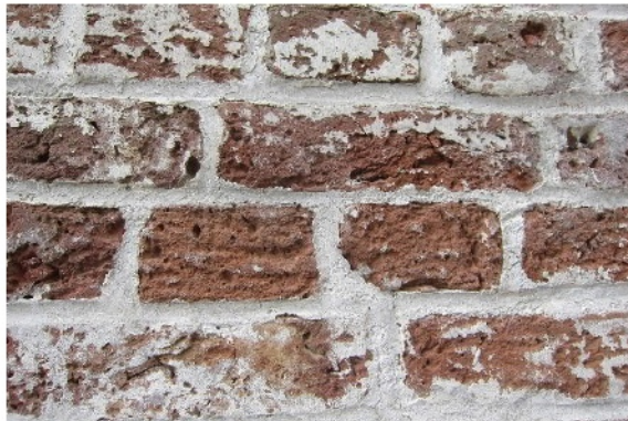
Abb. 167 weiße Beschichtung und Strukturschäden
