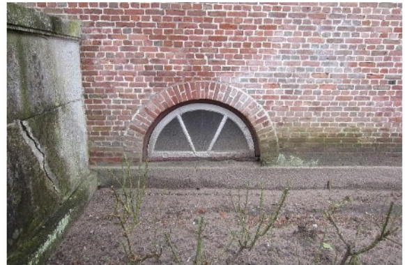
Abb. 172 weiße Schlieren auf Mauerwerk
