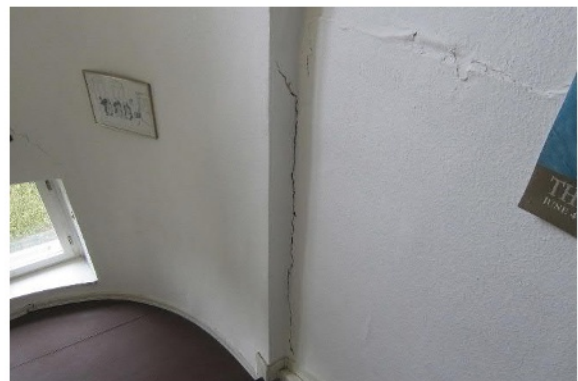
Abb. 10 Riss in der Mauerwerksverstärkung
