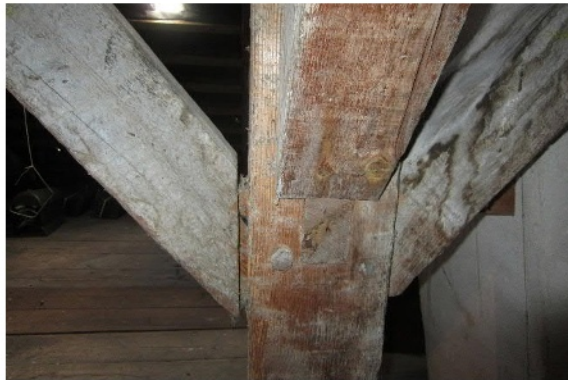
Abb. 148 offener Kopfbandanschluss
