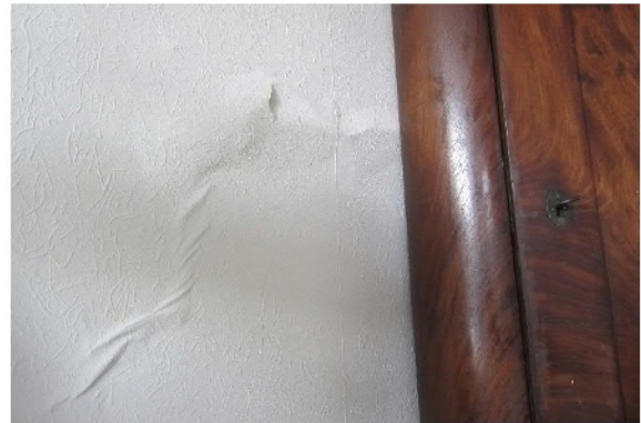
Abb. 94 Wandrisse in der hinteren Raumecke
