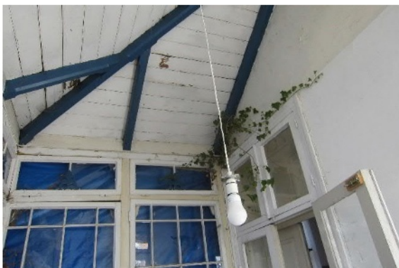
Abb. 31 Efeu wächst ein, Dachschalung geschädigt
