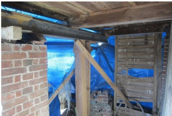
Abb. 29 Fehlende Eckstütze
