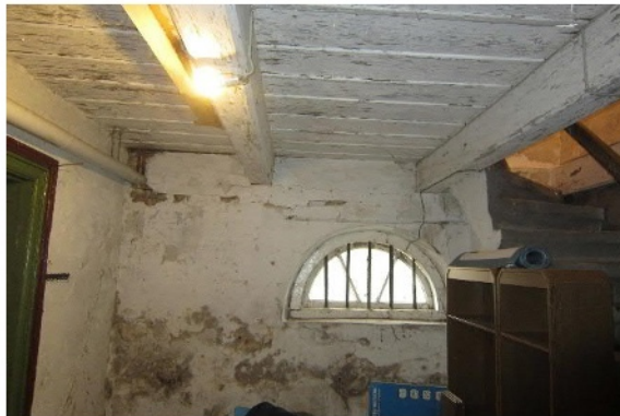
Abb. 34 Außenwand unterer teil Feucht
