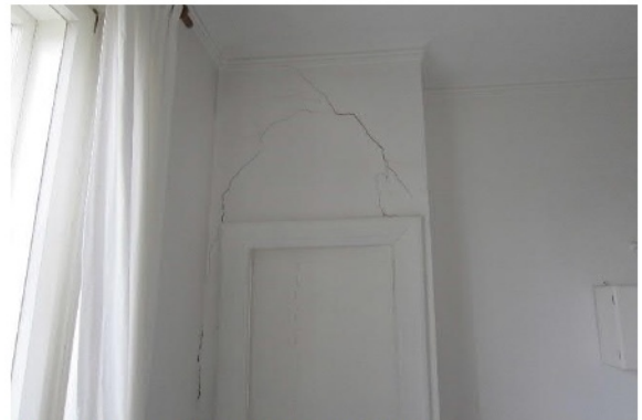
Abb. 133 Riss in Türsturz zu OG10
