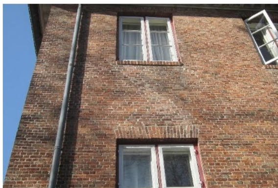
Abb. 181 sanierte Risse im Sturzmauerwerk
