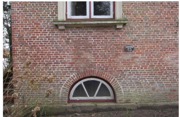
Abb. 174 Fugen großflächiger ausgebessert
