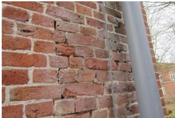
Abb. 169 ausgewaschene Fugen, erodierte Steine
