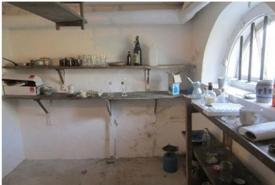
Abb. 72 Wanddecke Außen- und Querwand Feuchteschäden
