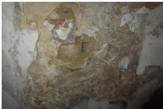
Abb. 46 Mauerwerksschäden Wohnungstrennwand
