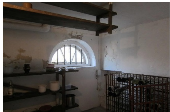
Abb. 71 Wandecke Außen- und Querwand Feuchteschäden
