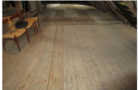
Abb. 162 Boden abgesackt
