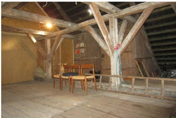
Abb. 146 Kehlbalken mit Holzbalken und Stützen
