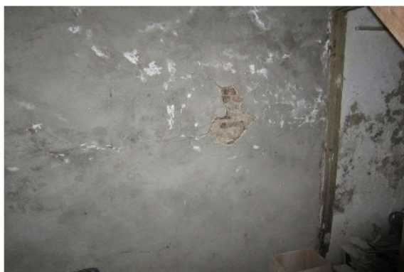
Abb. 66 Außenwand Putz löst sich ab
