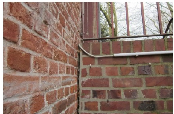
Abb. 22 Fuge zwischen Treppe und Gebäude
