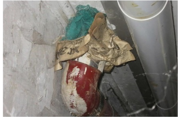
Abb. 51 Rohrabdichtung durch Decke
