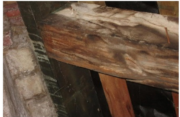
Abb. 156 Wasserflecken an Wechselsparren
