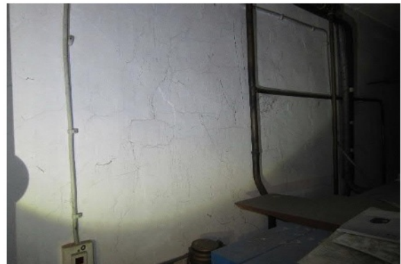
Abb. 53 Netzzrisse in Trennwänden
