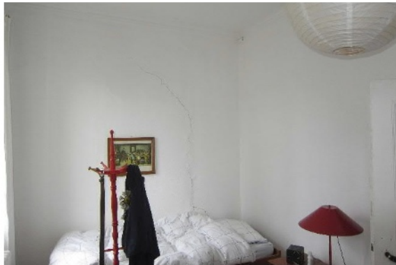
Abb. 138 Riss in Trennwand
