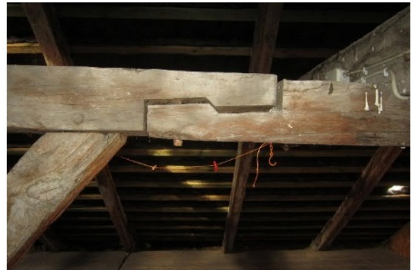
Abb. 149 Hakenplatt geöffnet
