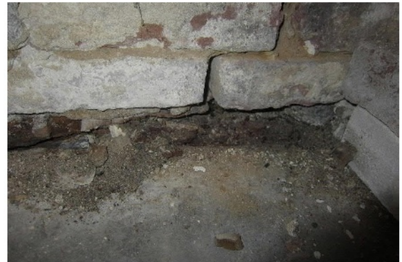
Abb. 41 Holzschwelle Querwand K02 und K03
