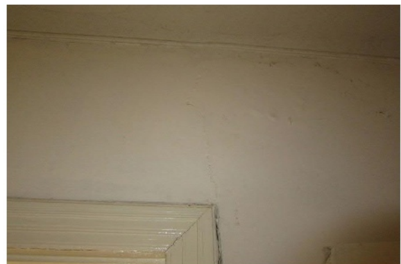
Abb. 117 Riss über Türsturz
