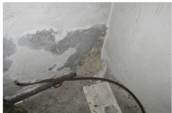
Abb. 55 Feuchtigkeit an Wandfuß
