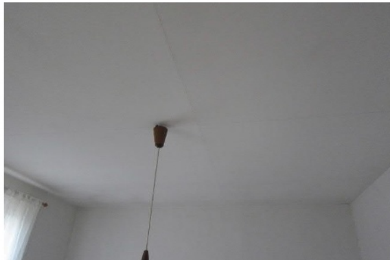
Abb. 134 Fugenrisse in Deckenplatten
