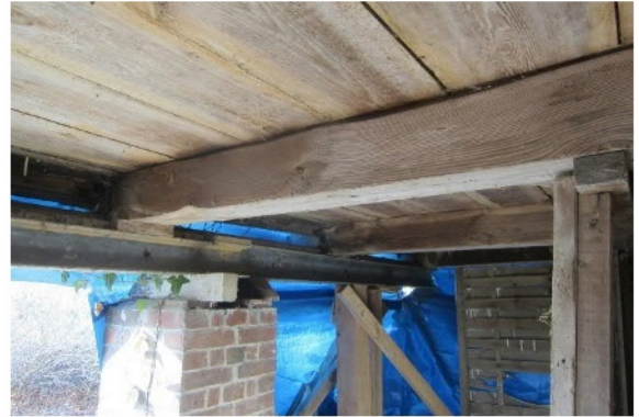
Abb. 26 Stützenaufleger Veranda (eine Stütze fehlt)
