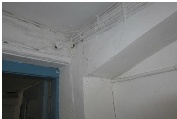
Abb. 58 gerissener Mauerwerksbogen
