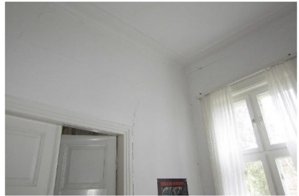
Abb. 98 Trennriss in Wandecke
