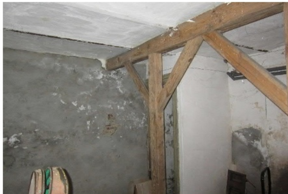
Abb. 64 Kappendecke mit Abstützung
