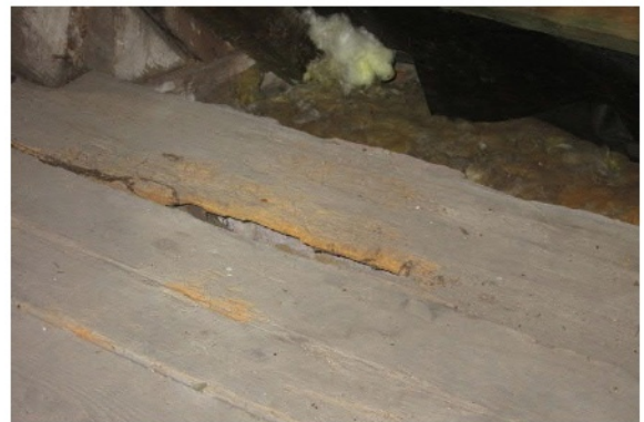
Abb. 160 vermuteter Insektenbefall (hier Dielung)
