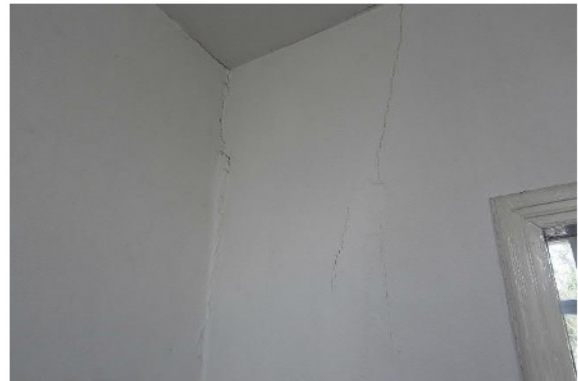
Abb. 108 Riss in Längswand
