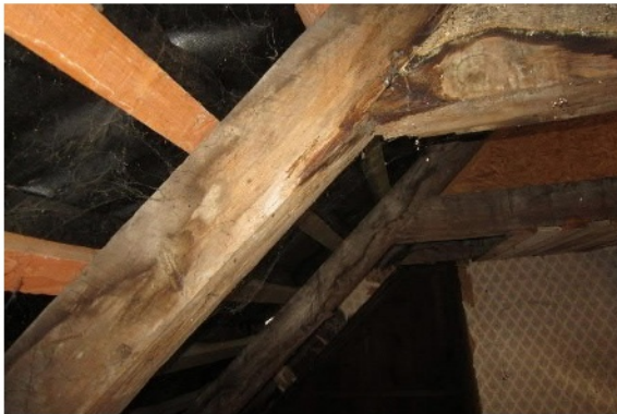
Abb. 155 Wasserflecken an Sparren und Kehlbalken
